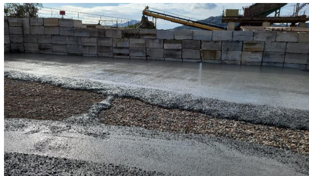
Figura 8 – getto calcestruzzo area messa in riserva R13 rifiuti inerti
