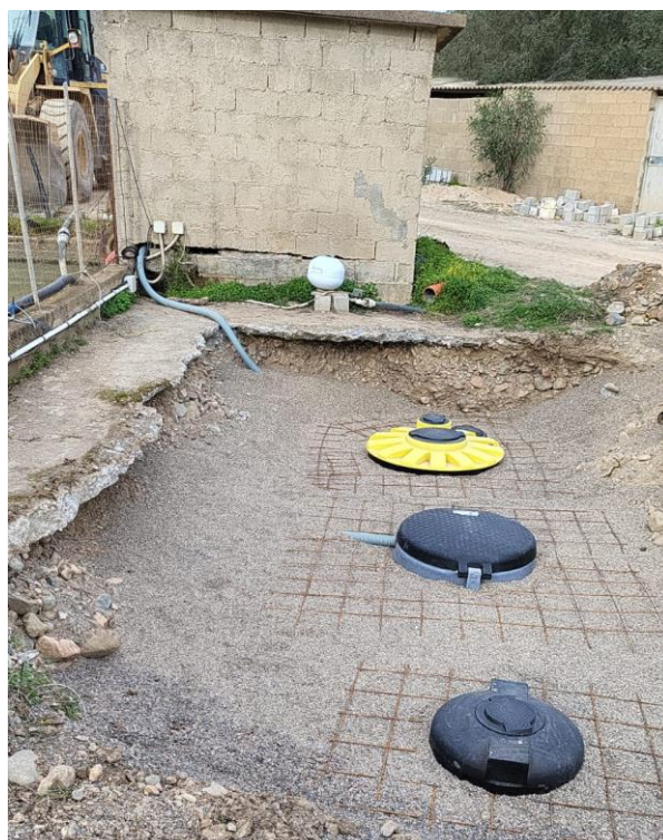
Figura 17 fase di ripristino scavo
