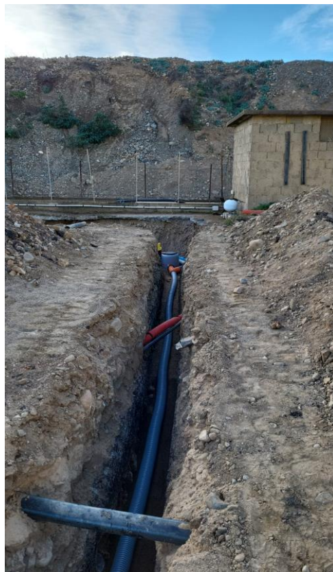
Figura 15 - posa tubazione sotterranea
