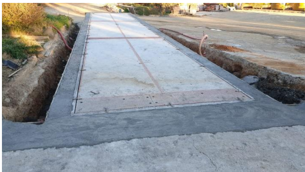
Figura 7 - Pesa a ponte in fase di installazione
